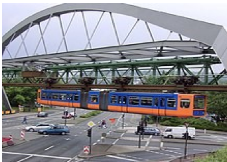
Un convoglio che attraversa in sopraelevata un grande incrocio
