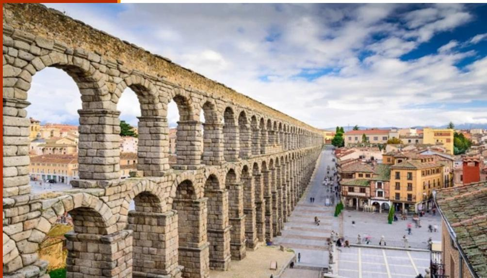
livelli che si adattano alla planimetria del terreno: si contano 75 archi singoli e 44 doppi, supportati da pilastri centrati gli uni sugli altri e costruiti a tutto sesto con blocchi di granito assemblati a secco. Fu costruito in una data imprecisata fra I e II secolo d.C., in seguito alla sconfitta dell'antico popolo indigeno dei Vaccaei e alla conseguente occupazione romana del
